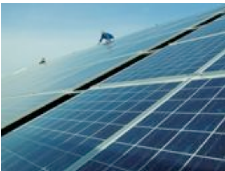
Installation der Photovoltaikanlage
