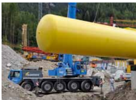
Anlieferung eines Flüssiggastanks
