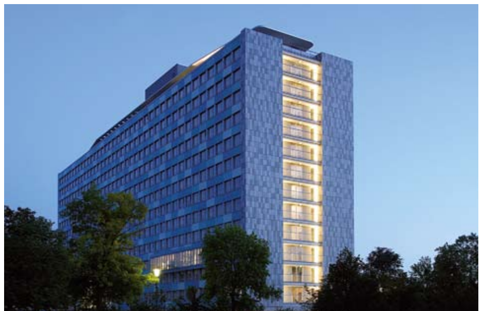
Das Statistische Bundesamt in Wiesbaden setzt auf Flüssiggas von Valentin.
