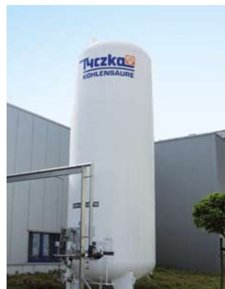
Flexibel, platzsparend und sicher: Installation einer 30-Tonnen-TND-Tankversorgung bei einem Lebensmittelunternehmen
