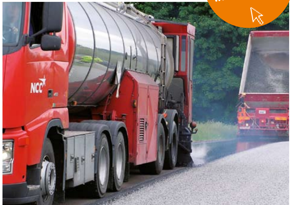
Verlegung einer Oberflächenbehandlung mit BIO-STYRELF 103
