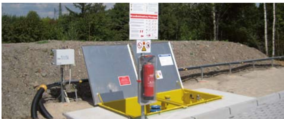
Erdgedeckter Doppelwandtank für DME mit Lecküberwachung
