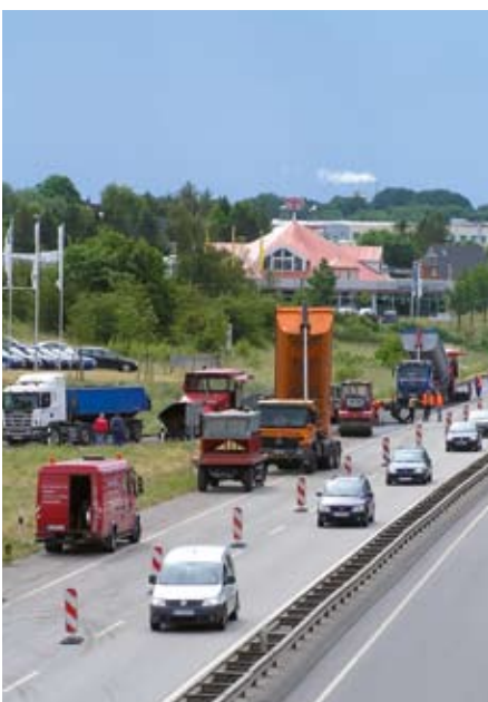
Asphaltbindereinsatz mit hohem Granulatanteil auf der BAB A7
